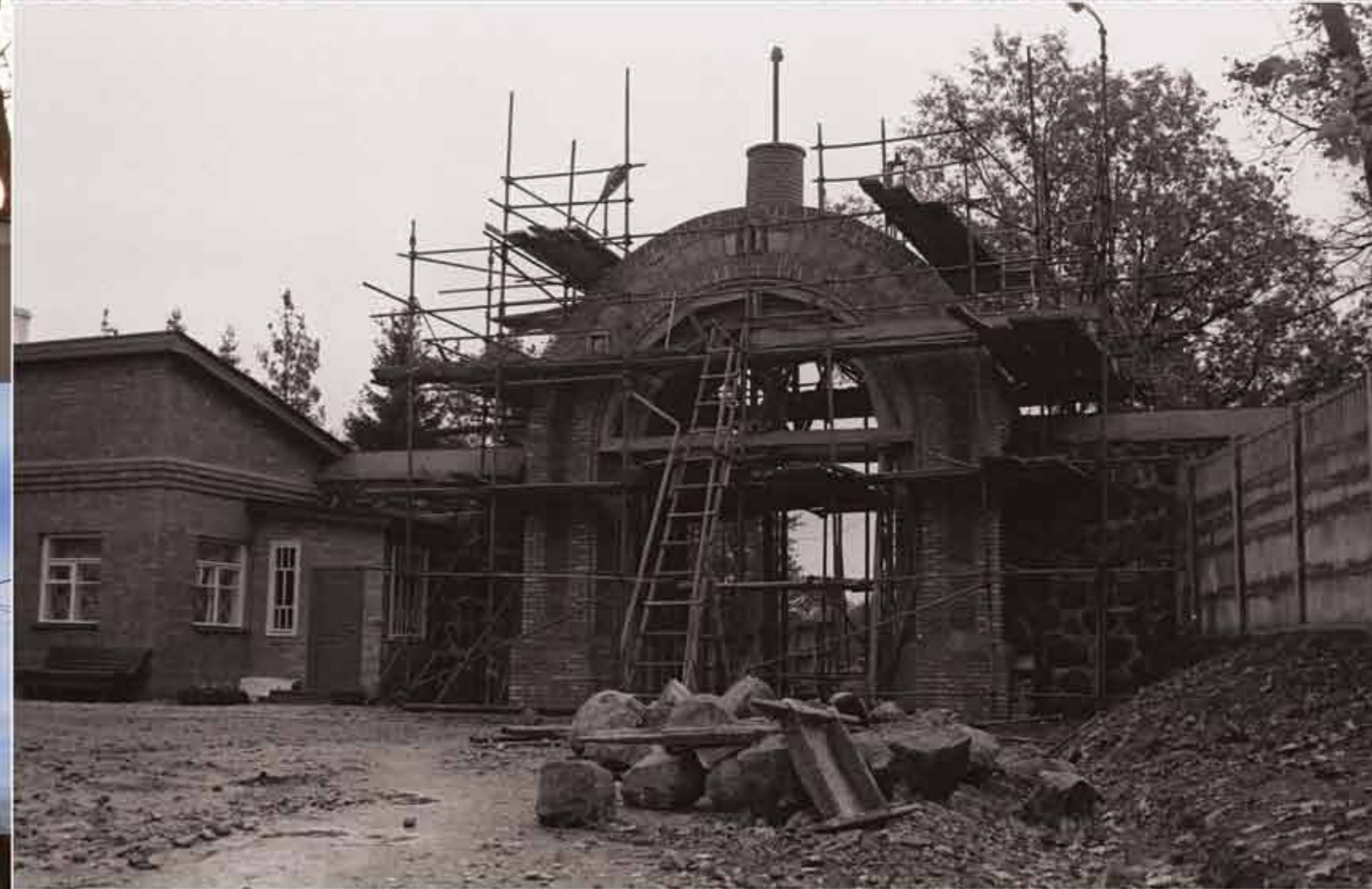
Строительство хозяйственного комплекса в Пюхтице. Юго-восточный въезд в обитель оформили кирпичной аркой. 1982 год
