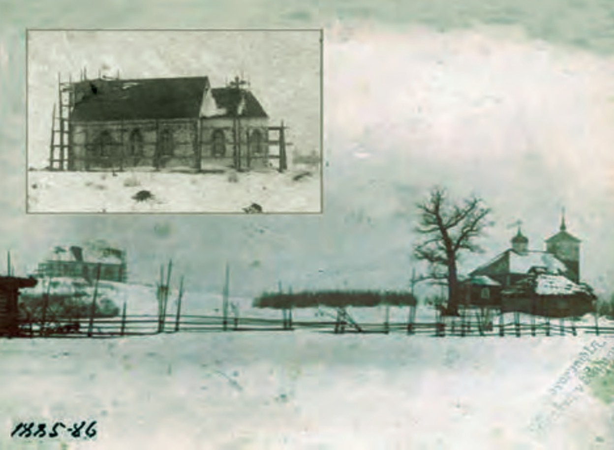
Строительство кирхи на среднем уступе Святой Горы
