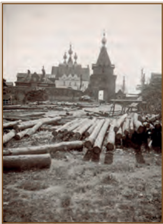
Строительство странноприимного дома. Лето 1901 года
