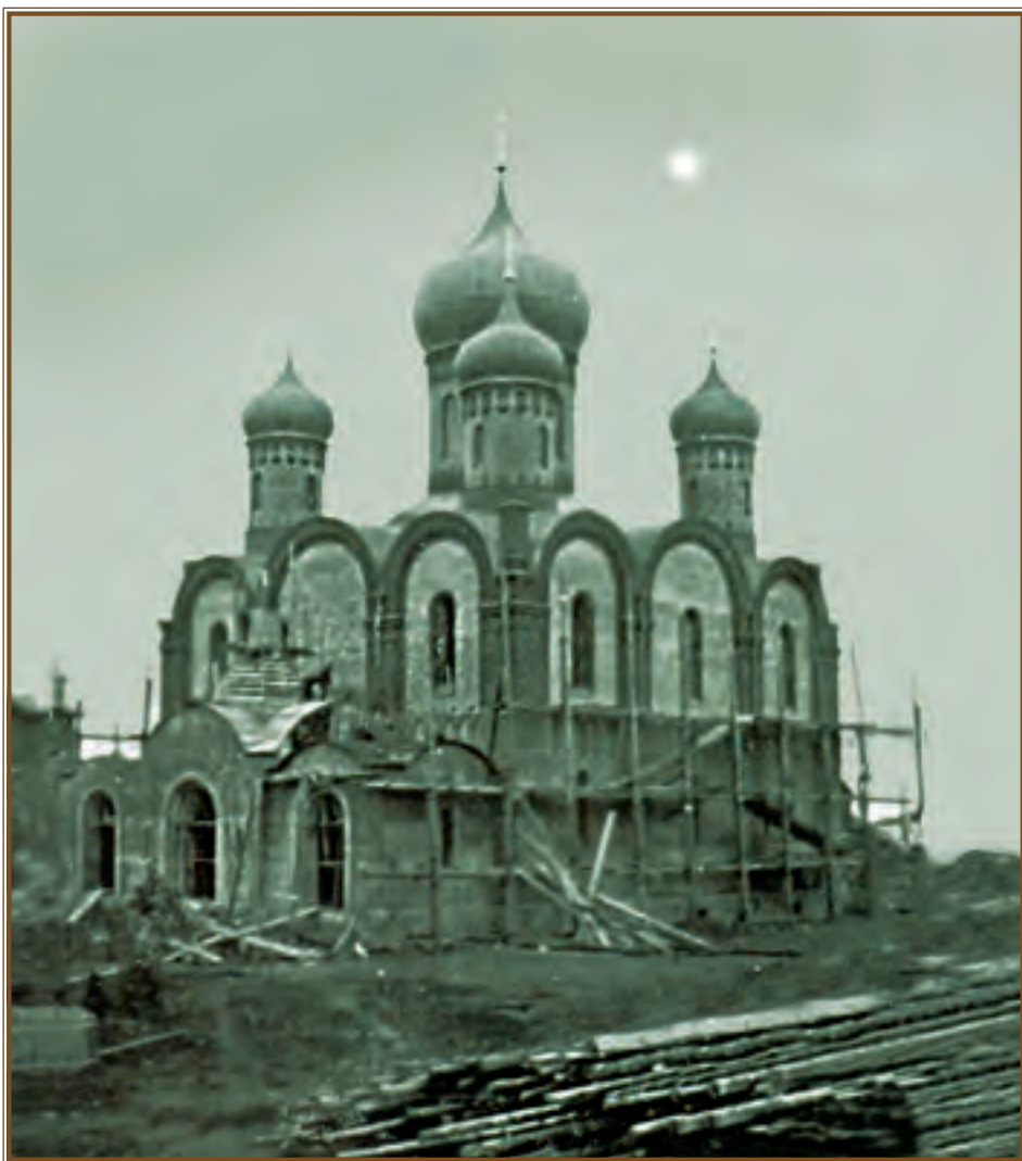
Строительство Успенского собора в 1909 году
